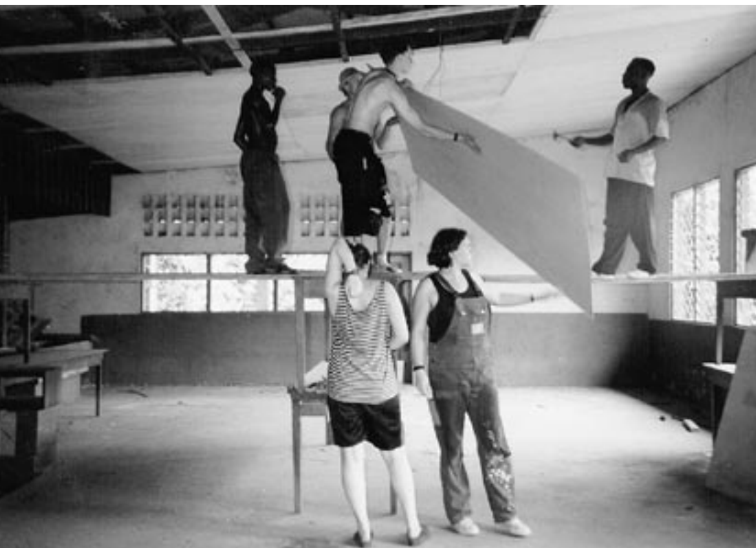
Der Speisesaal der „Presbyterian Secondary School“ wird gemeinsam renoviert.
