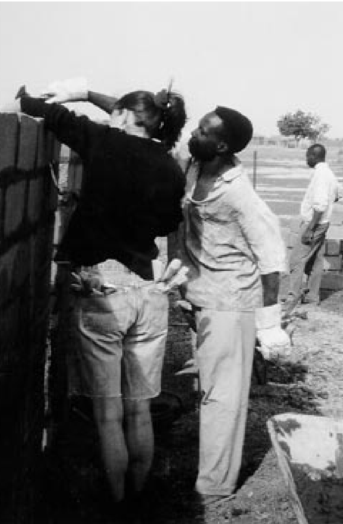
Die Umfriedung des Handwerkerzentrums wird unter fachkundiger Leitung gemauert. Foto: Ingrid Bethke
