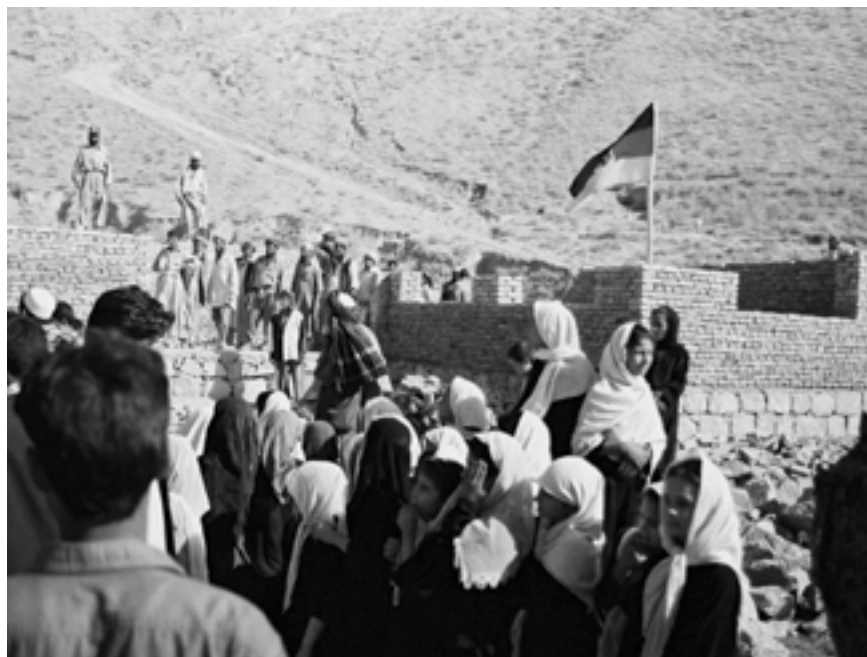
Bundeswehrsoldaten errichten gemeinsam mit einheimischen Bauarbeitern eine Schule in Chuga.
