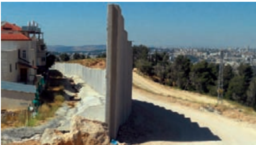
Die Mauer in AlWalajah. Das Loch, das hier zu sehen ist, wurde im Januar 2013 geschlossen.
