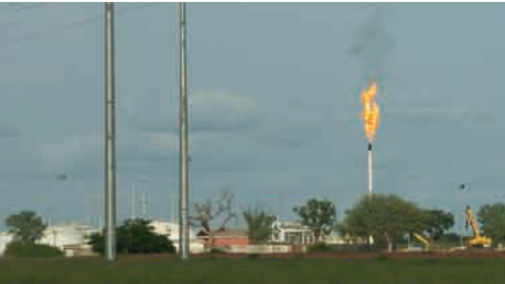
Erdölraffinerie im Tschad
