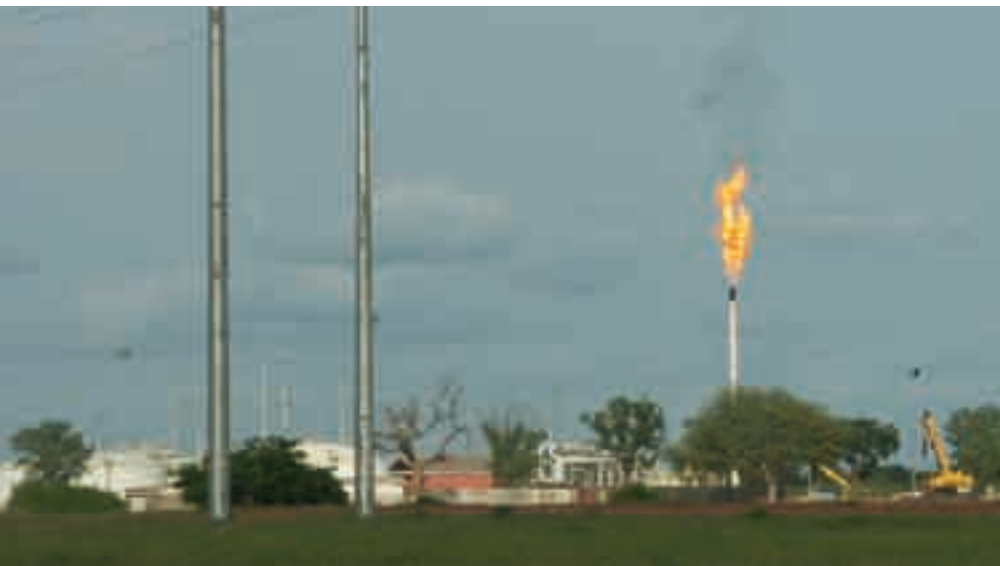
Erdölraffinerie im Tschad
