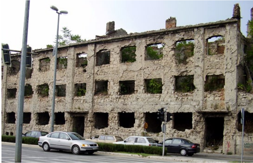
ZERSTÖRUNGEN DES KRIEGS SIND WEITERHIN IM STRASSEN BILD SICHTBAR
